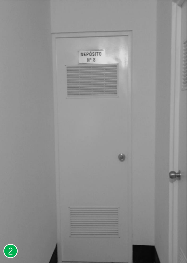
Ingreso de deposito, este se entregara con paredes y techo solaqueado
